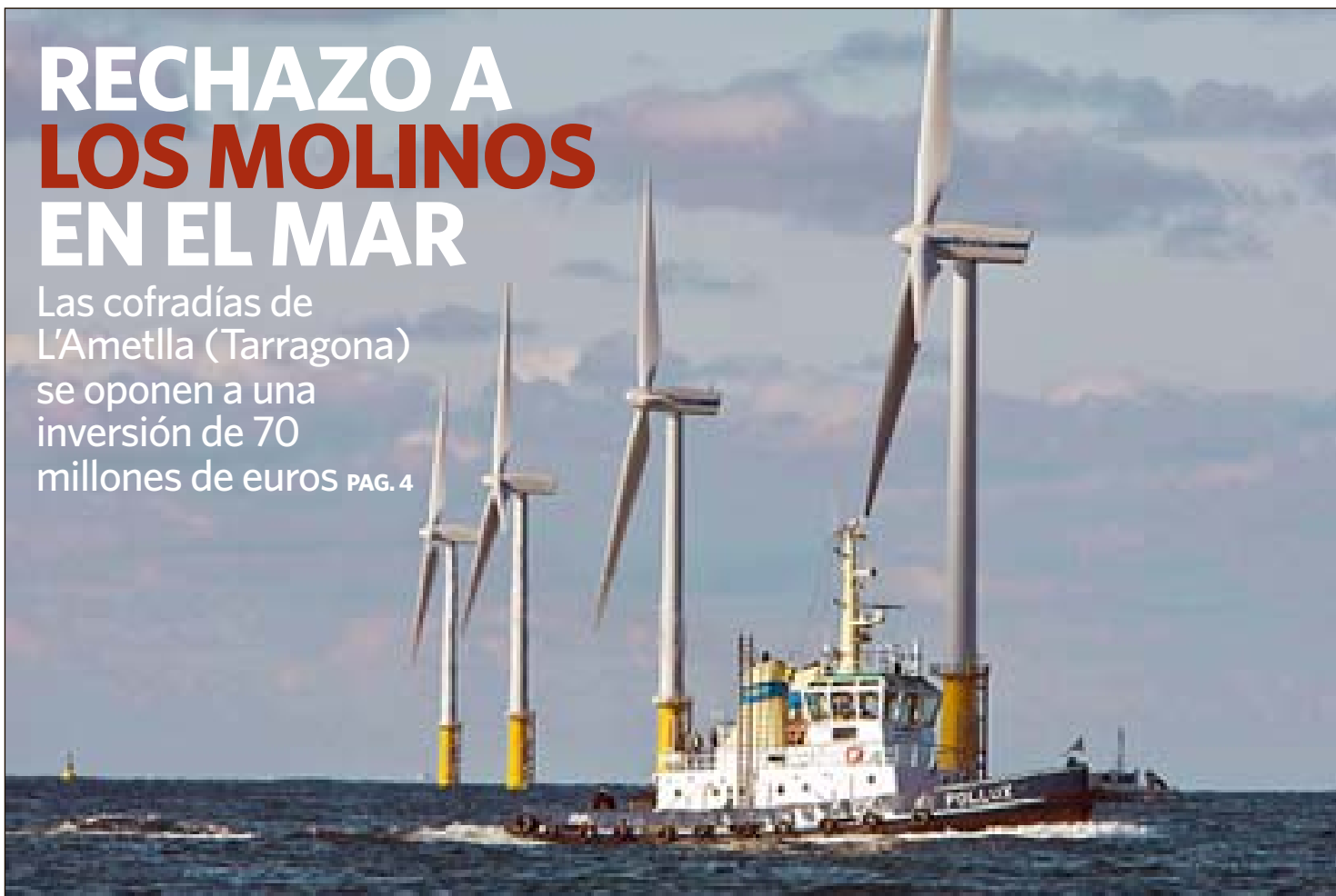
Aerogeneradores instalados frente a las costas holandesas. REUTERS
